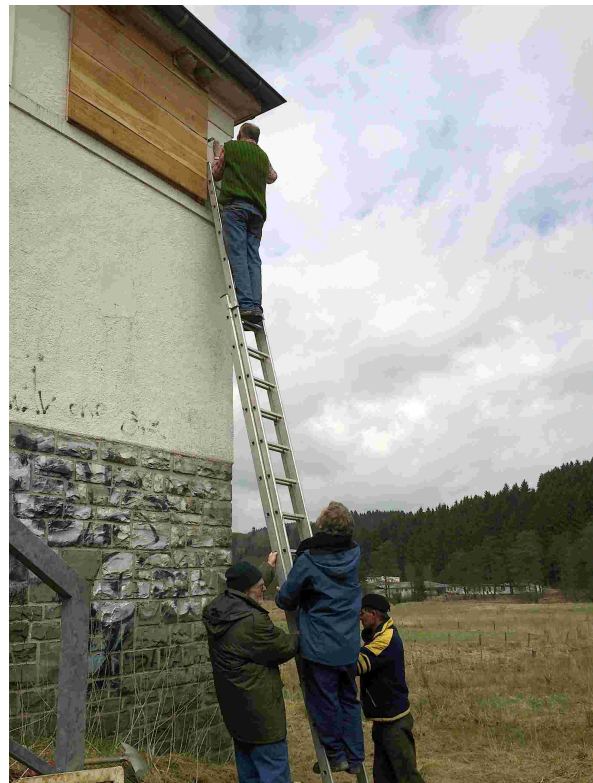
Über 20 Nistmöglichkeiten brachten die Vogelschützer an dem alten Traföhäuschen an – weitere Lebensraumverbesserungen werden folgen
